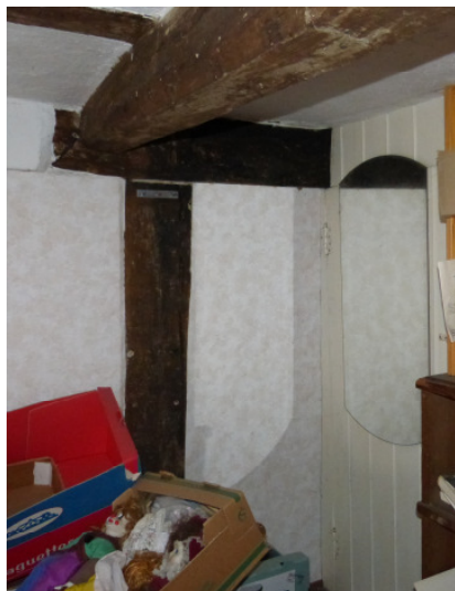
Abb. links: Abgesackter Rähm OG Giebel West
