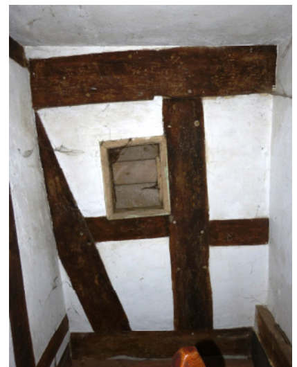
Abb. Mitte: Auf (nachträglich eingebrachter?) Fußpfette aufgelegte Sparren im DG
