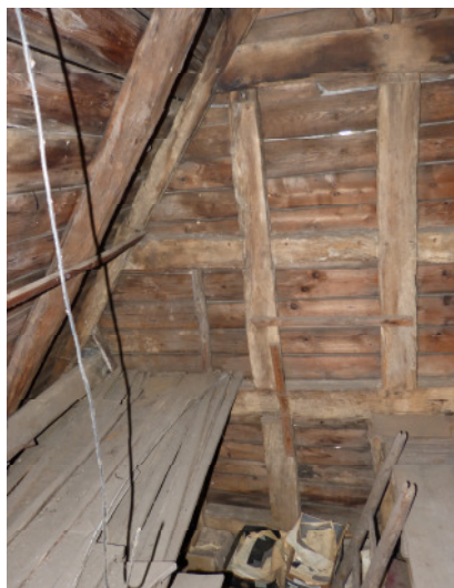
Abb. links: Abgesackter Rähm OG Giebel West
