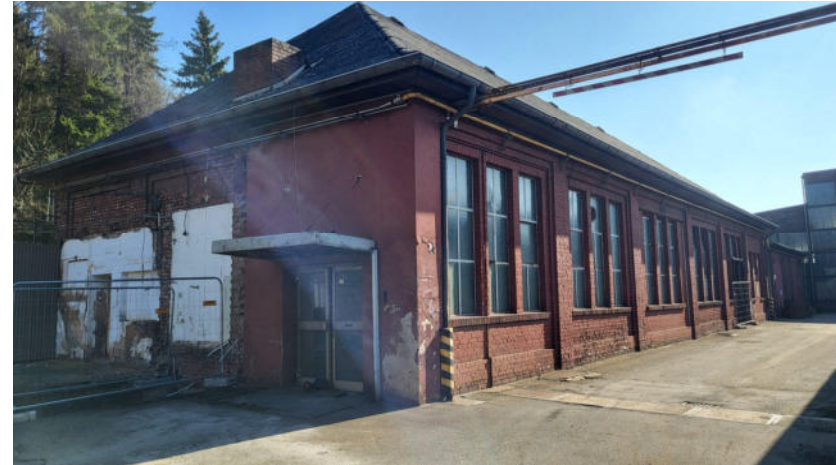
Gebäude Nr. 8 (Werkstätten)
