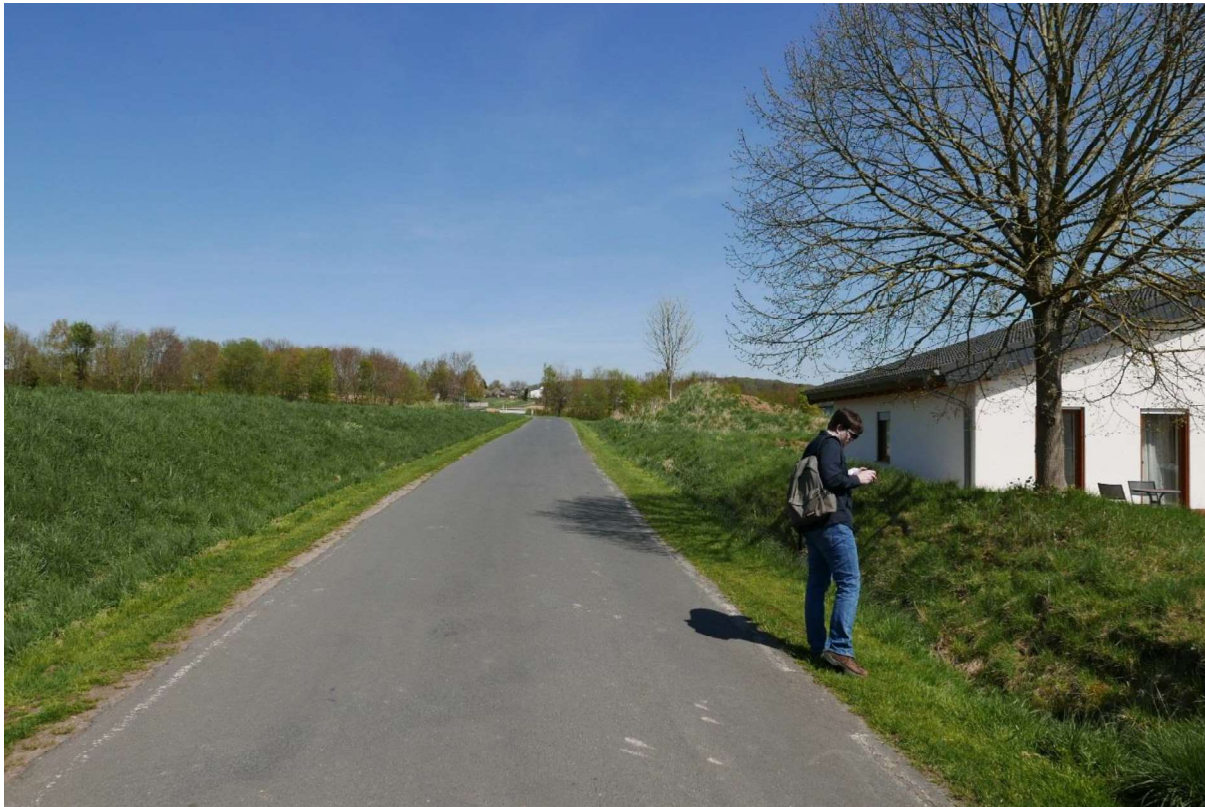
Blick nach Norden entlang der Diezer Straße. Das Plangebiet erstreckt sich beiderseits als einzellige Bebauung.
