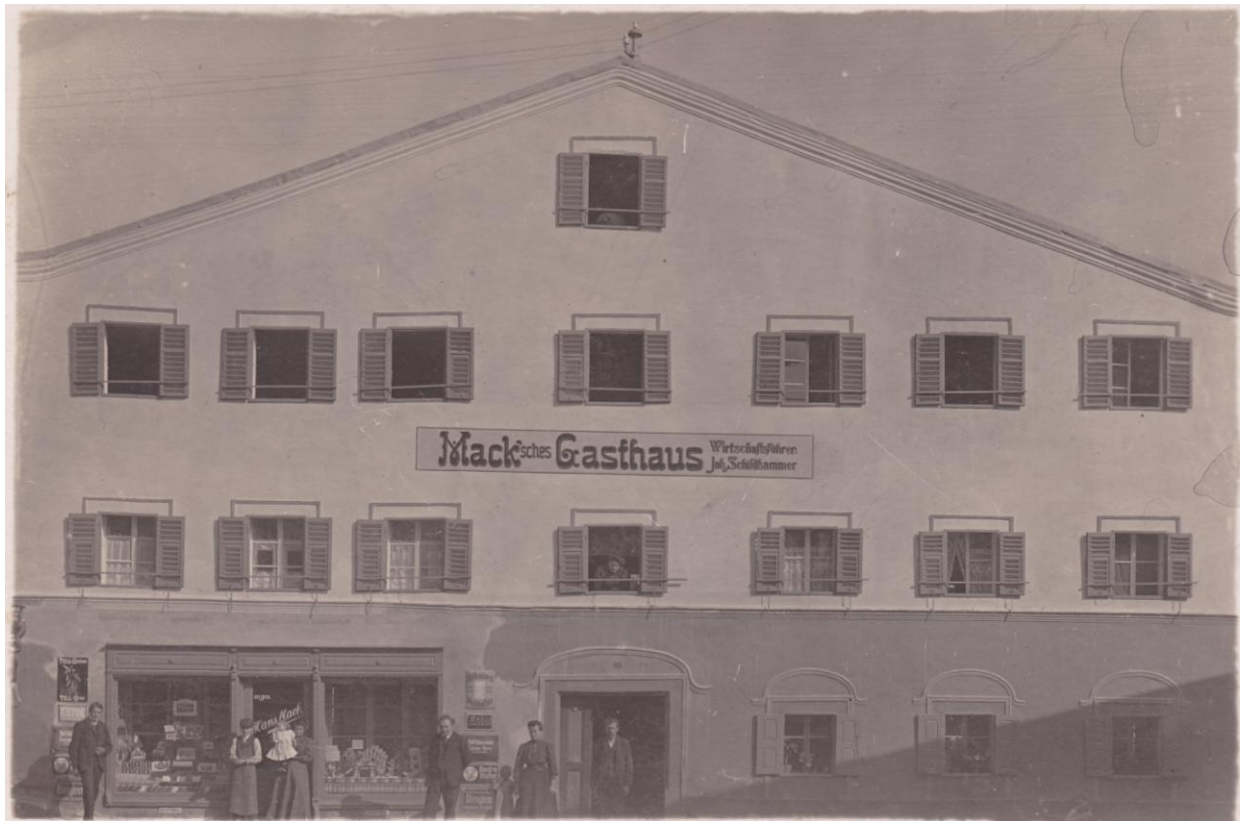
Ansicht des Hauses aus der Zeit um 1910. Verzierungen an den Fenstern. Türstock ursprünglich verputzt.
