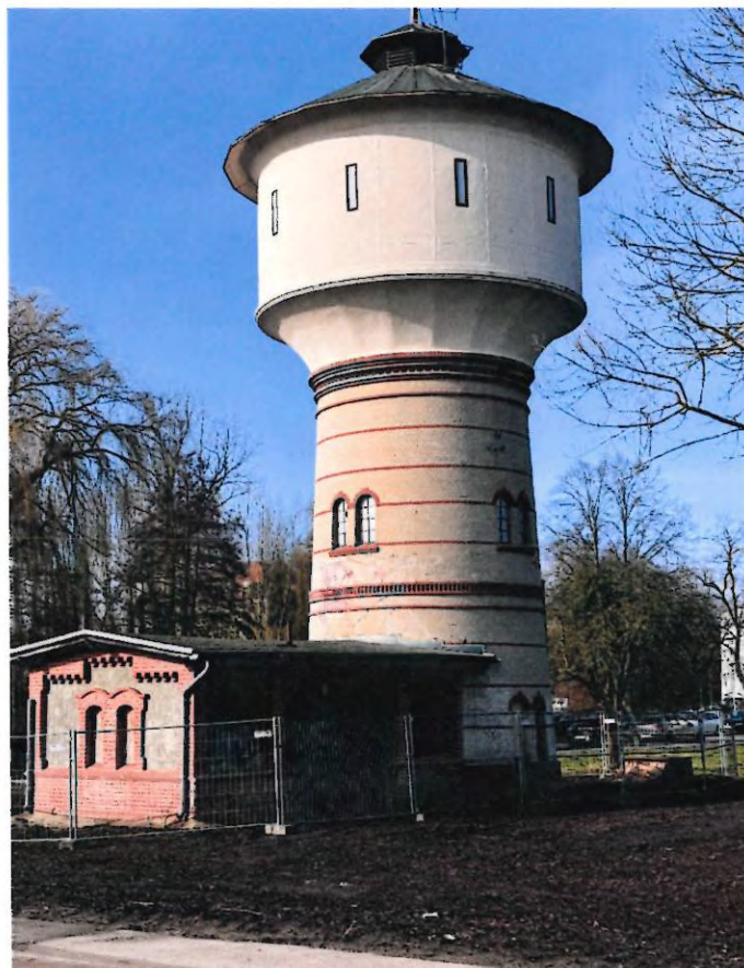
Bild 3: Wasserturm (02/2026) mit Pumpenhaus
