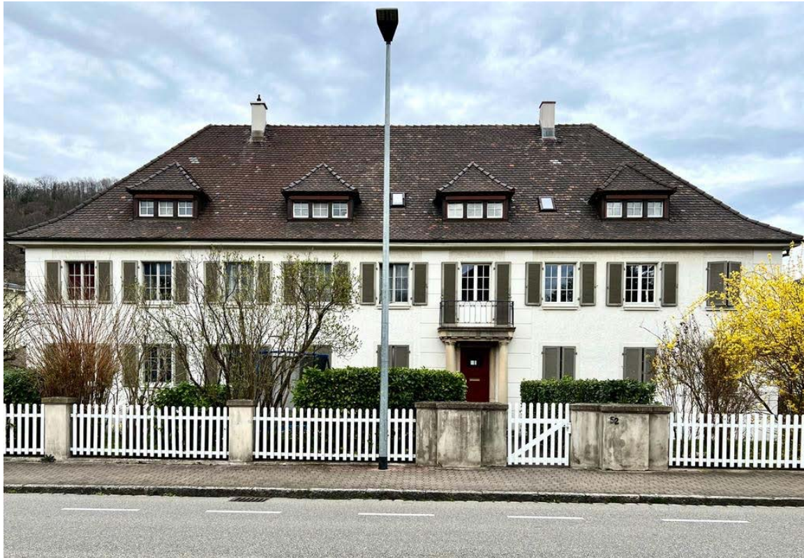
Fassade, Basler Straße 52
