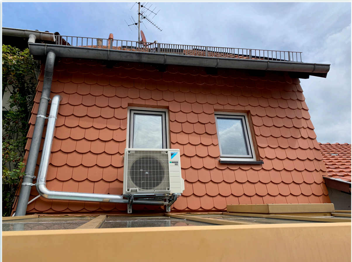
Rückseite des Hauses, mit Wintergarten und Klimaanlage
