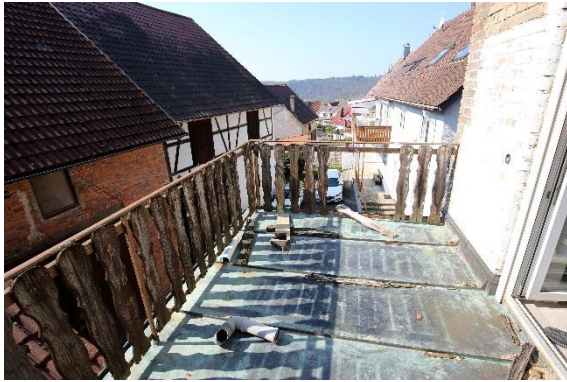
Balkon am Kinderzimmer (aktuell nicht nutzbar)
