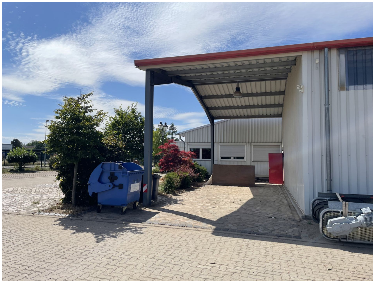
Lagerhalle mit Vordach 2 Türen (1x2m) und 2 Toren (4x4m)
