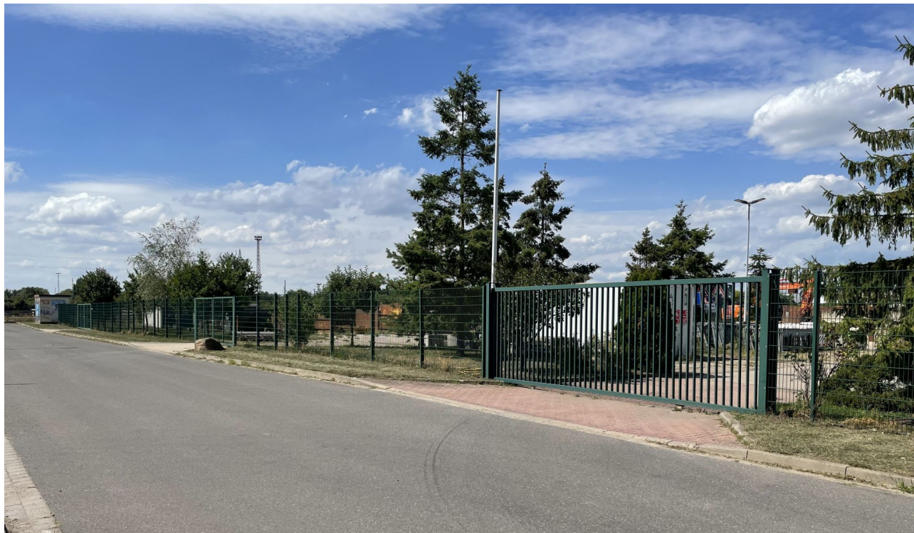
Zufahrt / Tor 1 mit Blick auf Büro und Halle
